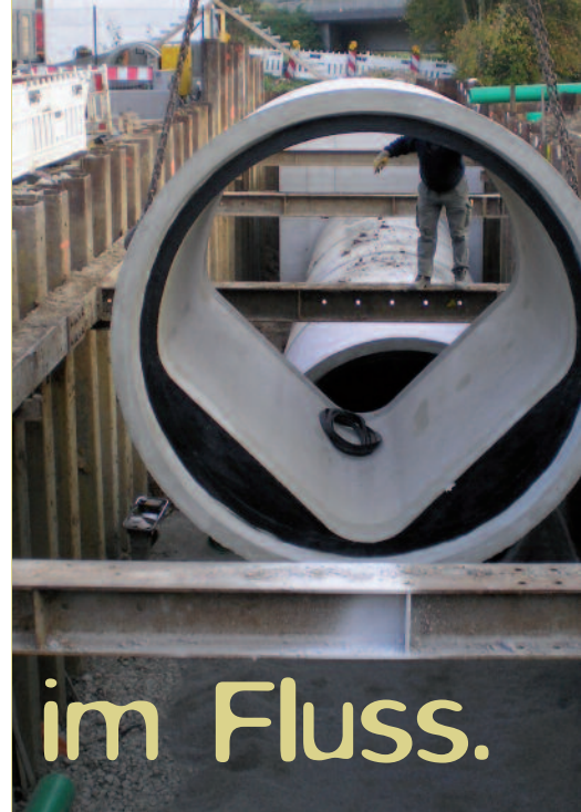
Umbau Regenüberlaufbecken Dettingen
